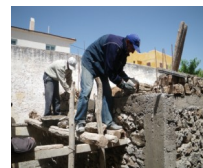
Construction du réservoir - Juin 2010
