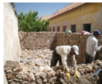
Construction du réservoir - Juin 2010
