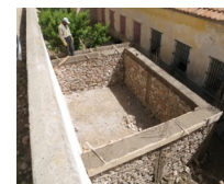
Construction du réservoir - Juin 2010
