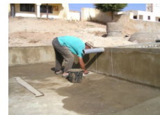
Construction de la paroi du filtre - Juin 2010
