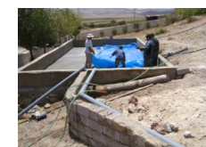
Installation des tuyaux et du massif filtrant - Juin 2010
