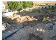
Travaux de terrassement - Juin 2010
