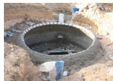
Construction du digesteur anaérobie - Juin 2010
