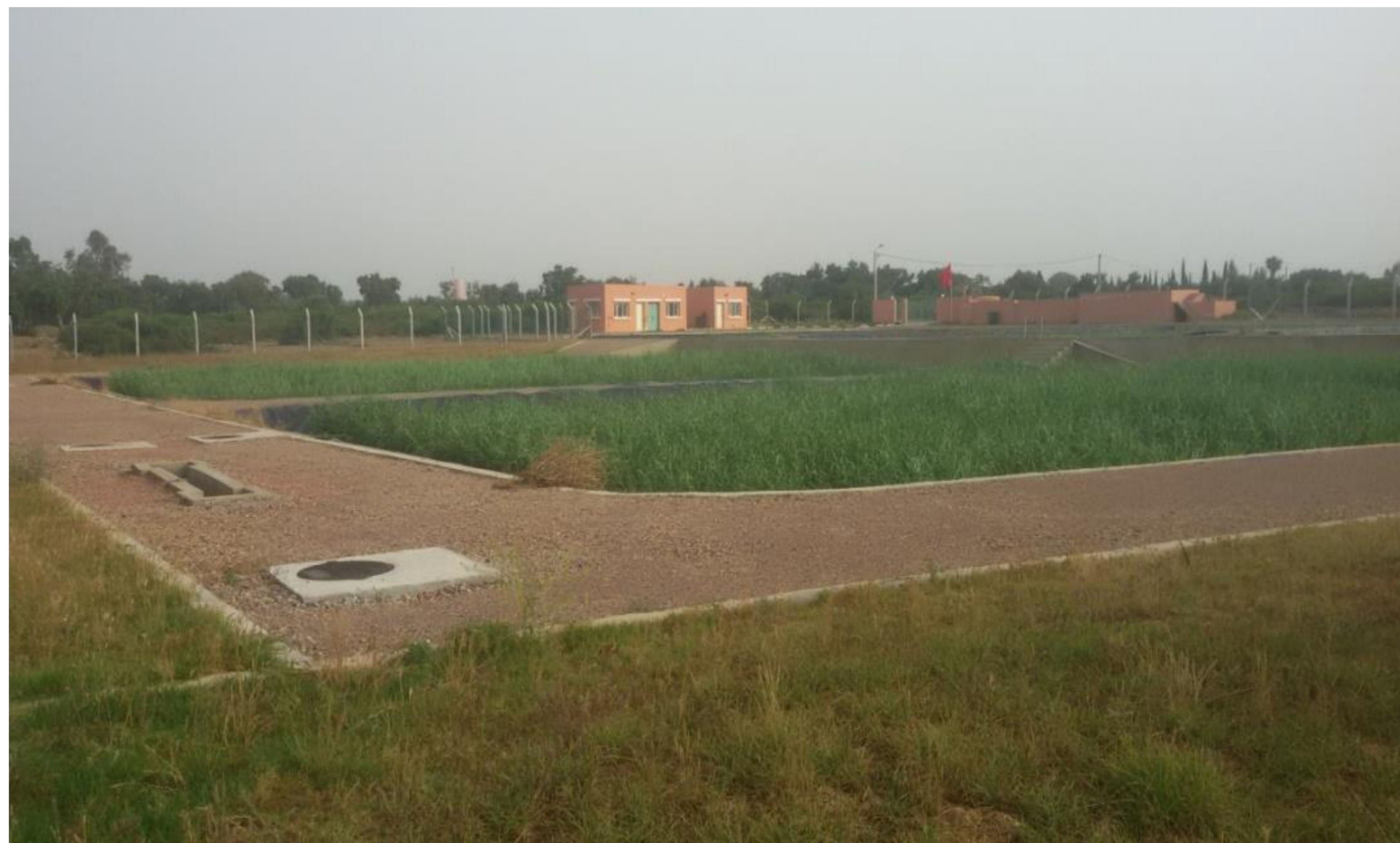
Vue des filtres plantés du deuxième étage de la STEP de Laayoune Source : Service provinciale de l'eau, DPETL de Benslimane
